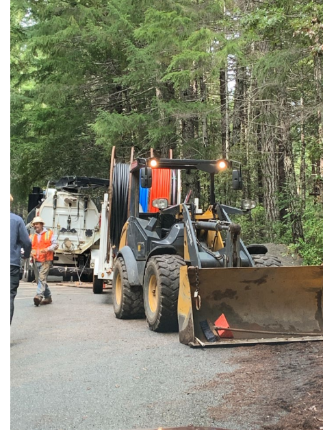
Trenching for conduit
